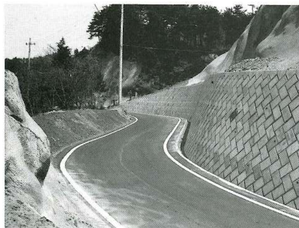
村道下の前34号線改良舗装工 事(16区内) 幅員4m 延長244m
