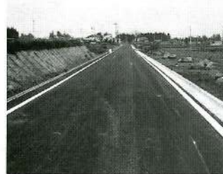
団体営農道整備事業宿戸尻地区 17、18、19区にかけて総延長590mが 整備されました。幅員は5m
