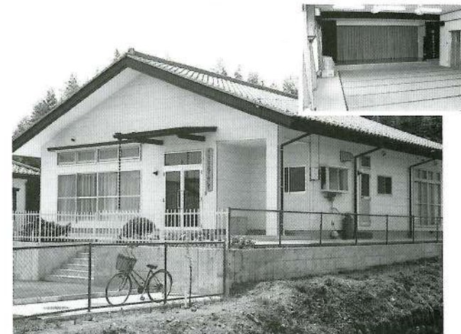
コミュニティ センター 8区コミュニティセンターは防 衛の補助事業として建設された もので、12、5、18、9、4、2、1、 14、7区に次いで10番目。
