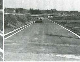
小規模土地改良事業中組農道 (1区内) 幅員6m 延長196m
