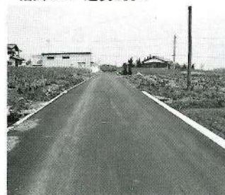
村道下の前34号線改良舗装工 事(16区内) 幅員4m 延長244m
