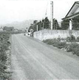
布海道内農道改良舗装 工事(2区内) 幅員4m 延長173m
