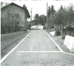
村道上サ3号線改良舗装工事 (13区内) 幅員4m 延長95m
