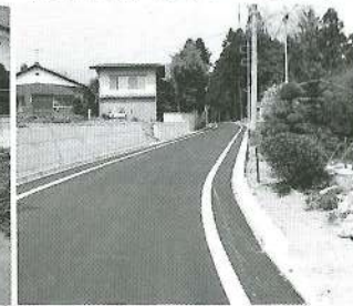
村道合・滝沢線改良舗装工事 (3区内) 幅員4m 延長457m
