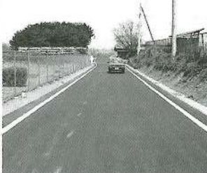
村道新井高塚5号線外3改良舗装工事 10、11、20区にかけて総延長669mを整備。幅員5
