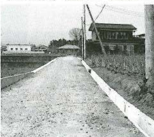
村道八ノ海道23号線改良工事 (14区内) 幅員4m 延長87m
