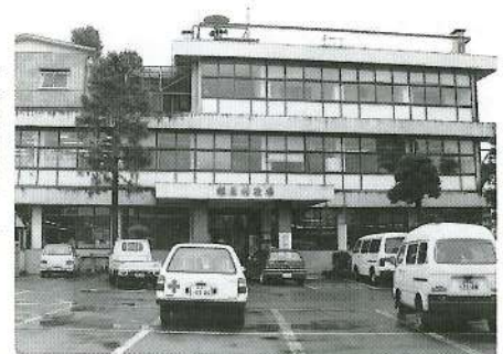
建設後30年が経過し、手狭まとなっている役場庁舎
