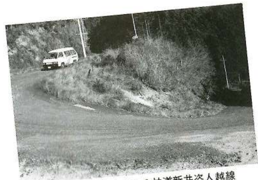
改良舗装が進められる林道新井盗人越線
