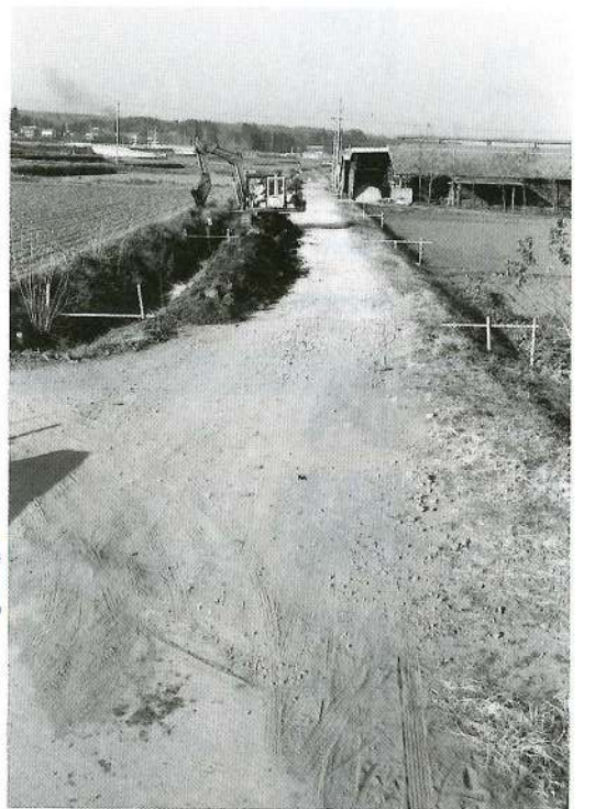
農村基盤総合整備事業で整備される長岡市内の農道
