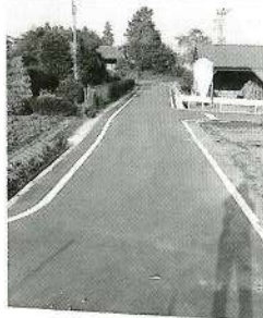
中の前地区で整備された農道(延長269m)
