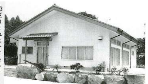
13区コミュニティセンター鉄骨造瓦葺平家建床面積は147.36㎡
