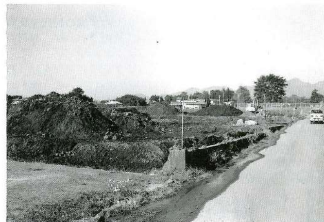
造成が始まった南部コミセンの建設用地——平成3年度に建物本体工事、4年度に附帯工事が行われる
