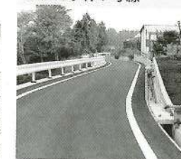
350mにわたって改良舗装された小林1号線
