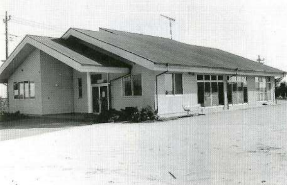
昭和58年に建設された「榛東村児童館」
