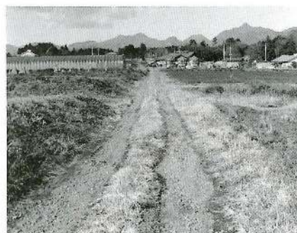
改良舗装されることになった宮室46号線
