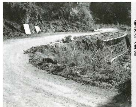
改良舗装が進められている新井盗人越線
