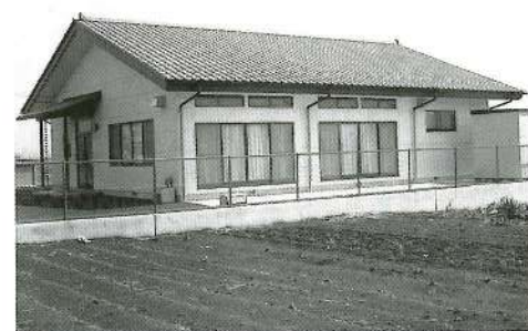
完成した16区コミュニティセンター
