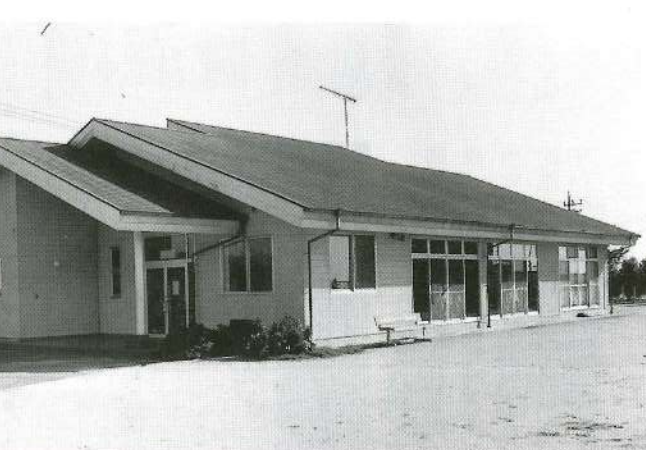
3区地内にある児童館。館内には遊戯室や図書室などがあり、開館日1日平均当たり23人の利用がある。
