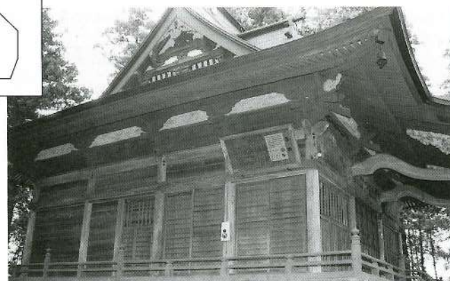
「算額」柳沢観音堂の南側壁面に奉納された
