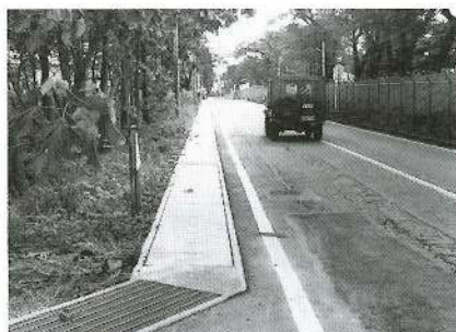
駐屯地前排水路
