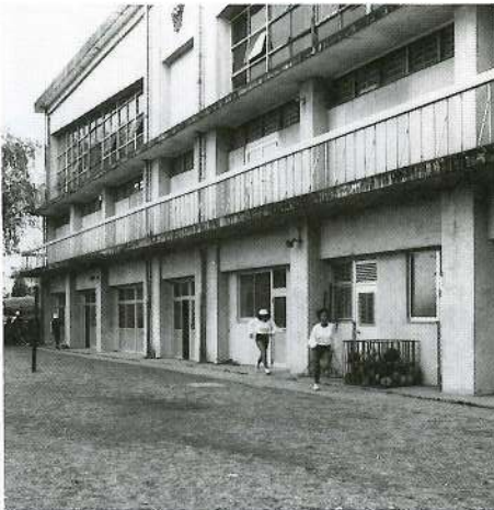
改修された中学校の部室およびトイレ
