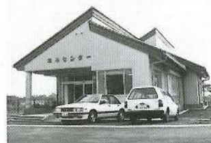
楽集センター 鉄骨造瓦葺平家建 床面積は 288㎡
