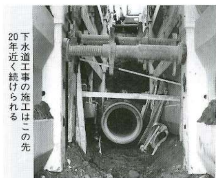
下水道工事の施工はこの先 20年近く続けられる
