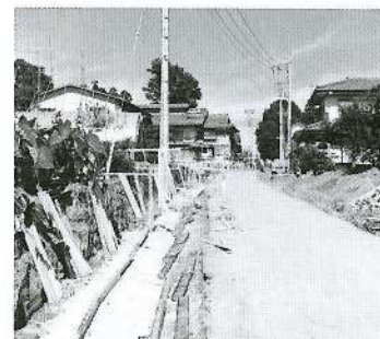
現在、幅員拡幅工事が進められている4区区内の村道
