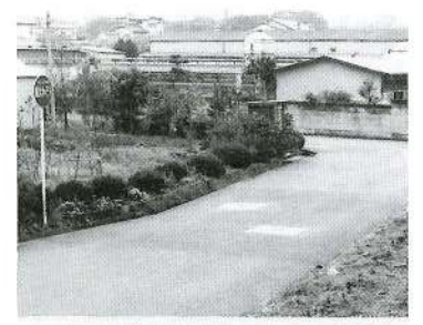
21区地内に新設された防火水槽
