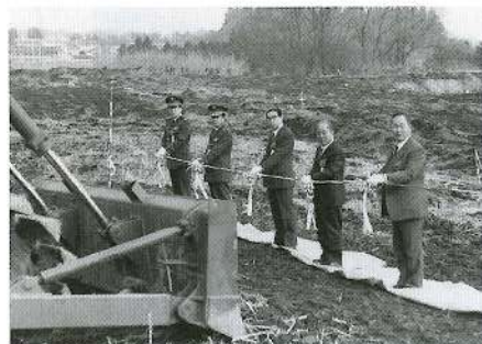
ブルドーザーの前で行われたテープカットの様子
