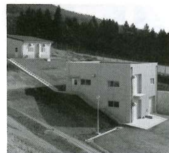
453,200,000円の費用を投じて作られた処分場の浸出水処理施設
