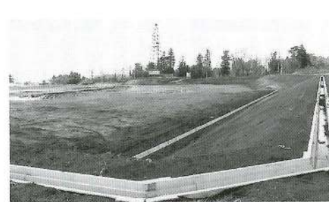
福祉ふれあいセンター(仮称)の着工を待つ広場
