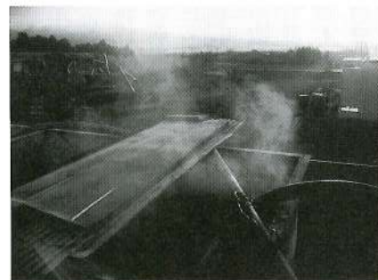
温泉資源開発掘削工事現場。撮影はことしの二月二十五日早朝
