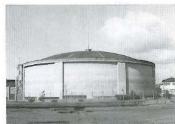
平成7年度に建設を予定している配水地（参考写真）
