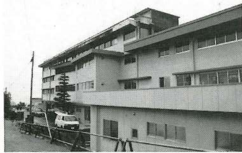
第一期の改造工事が完了した中学校の北校舎
