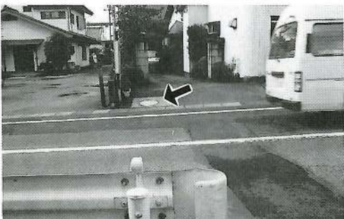
矢印で示されているのが公共汚水ます
