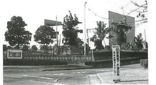
本村の下水は（公共下水道の場合）、延長約30%の管路を経て、玉村町にある県水質浄化センターへ到着する。その所要時間は約6時間
