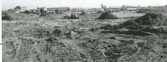
新井地内で整備がすすめられている村営八幡土地改良事業
