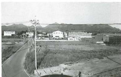
南部浄水場が望む上野地区工業団地。写真の左手前から奥に延びるのは村道上野8号線
