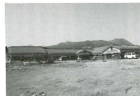
4月末のオープンに向けて急ピッチに工事がすすむ「しんとう温泉ふれあい館」
