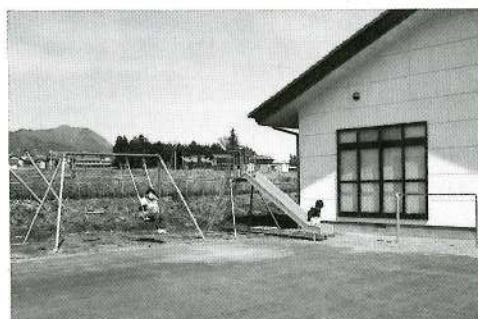
ちびっ子広場は、小さなスペースでも子どもには魅力ある空間です（写真は17区）
