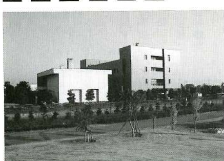
1987年10月に稼働した玉村町の県央水質浄化センターへ本村の下水（公共下水の場合）も
