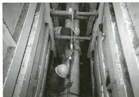
公共下水道工事で埋設された管も、いよいよ来年4月から重要な役割を果たすことになる
