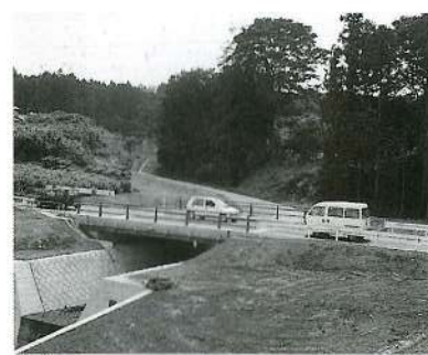
県の蛇ヶ見川砂防事業により上野幹線道路に完成したふれあい橋
