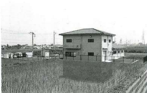
処理能力1180人槽をほこる吉岡町の上野田農業集落排水処理施設。その管路は9788メートルにおよぶ
