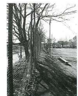
防球ネットが張られた総合グラウンドの東側
