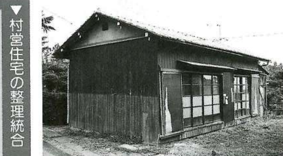
昭和37年度に建設された大宮住宅。同年は、西帝住宅も建設され、合計13棟が建てられている
