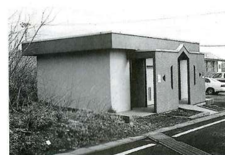
近所の方に清掃を委託して美化に努めている総合グラウンドのトイレ
