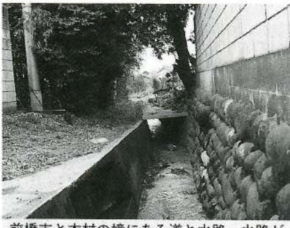
前橋市と本村の境にある道と水路。水路が橋東村で左の道は前橋市の市道
