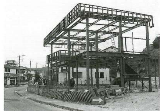
▼建設中の20区コミセン
