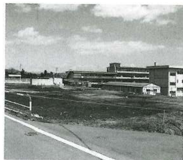
造成工事が終了した中学校体育館建設予定地
