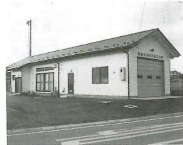
棟東駐在所西側に建設された第3分団の消防詰所。消防車庫、第3分団の詰所、ラッパ隊の詰所になっています。
