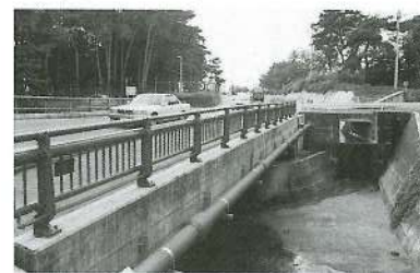
完成した末広橋
