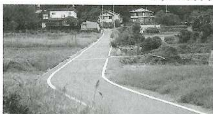
整備された清水貝戸地区
