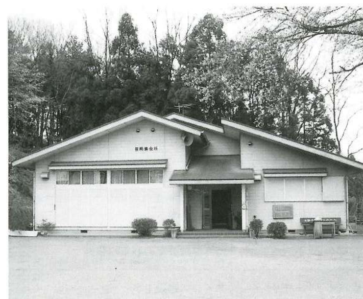
改修予定の笹熊集会所
