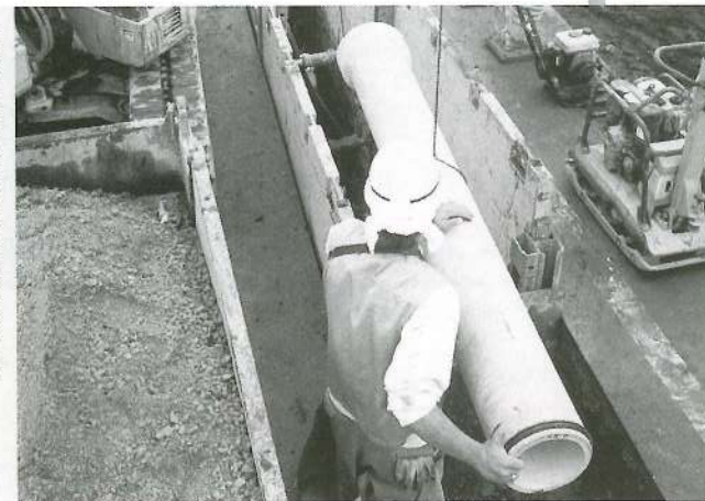
順調に進行している公共下水道工事
