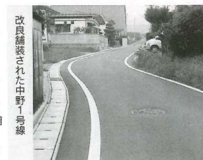
歩道が整備された八幡ふれあい広場線
