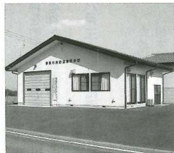
新築された消防団第4分団詰所
