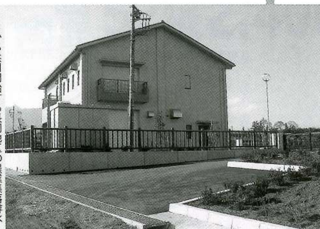
7月から供用開始する長岡地区の農業集落排水処理場
