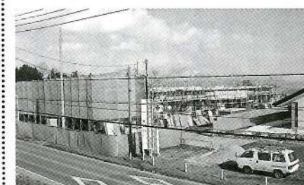
建設中の社会体育館
