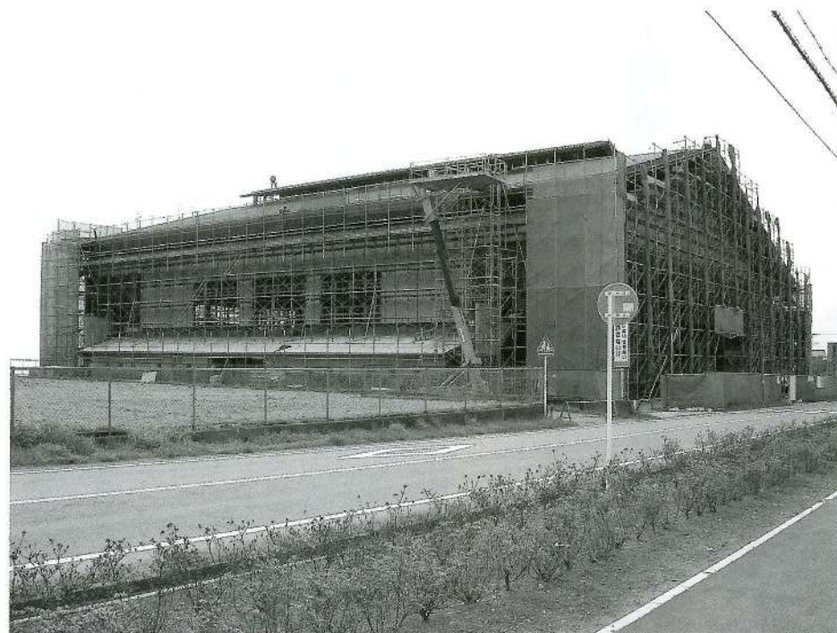
八月の完成を目指し着々と整備が進む社会体育館。今年度は駐車場などの外構を整備する予定です。
