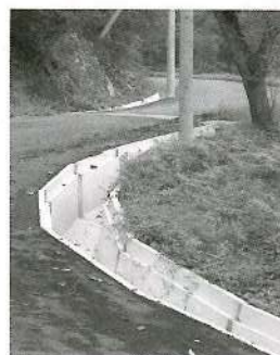
側溝が改良された林道新井盗人越線
