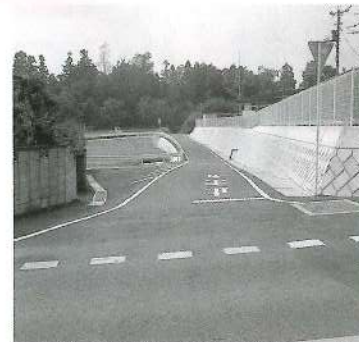
改良舗装された西帝1号線
