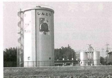
完成した壁画付きの水道タンク
