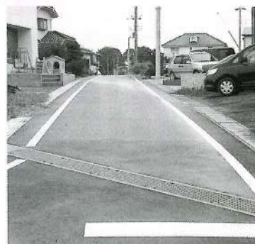
改良舗装された八ノ海5号線
