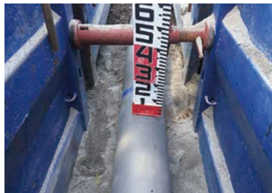
100年持つダクタイル鋳鉄管GX形の布設
